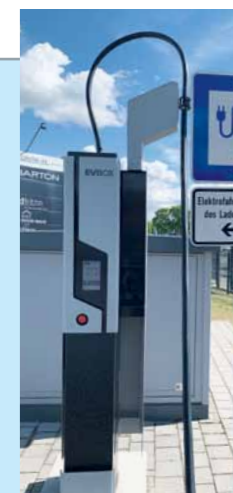
Eigenwillig: An dieser Station klemmt das Ladekabel zwischen den Hinweisschildern.
